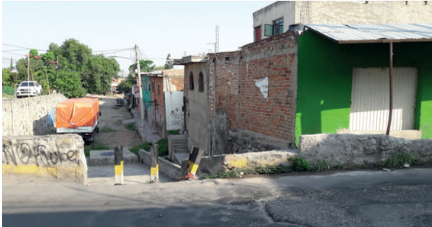
Figura. 15 Calle Mandarina vista desde la calle Pera. Fotografía del levantamiento de julio 2017
